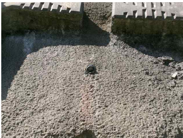
앵커부 수평배수공 전경
