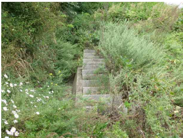
산마루측구, 점검계단 전경
