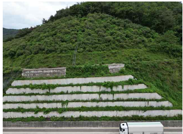
사면내 옹벽 전경
