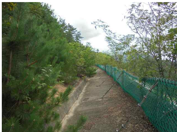
1소단 배수로 전경
