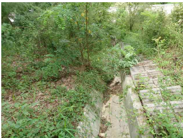
점검계단, 산마루측구 전경
