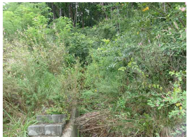
산마루측구, 점검계단 전경
