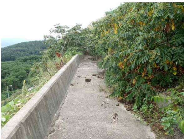
2소단 배수로 전경
