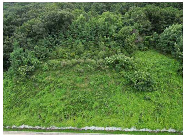
사면부, 하단 판넬형옹벽 전경
