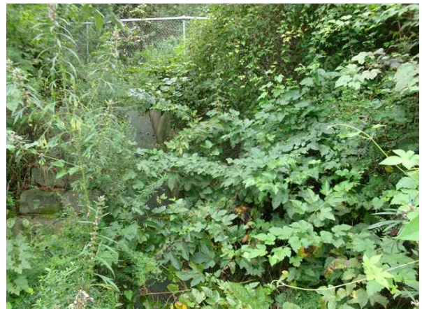
산마루측구, 점검계단 전경
