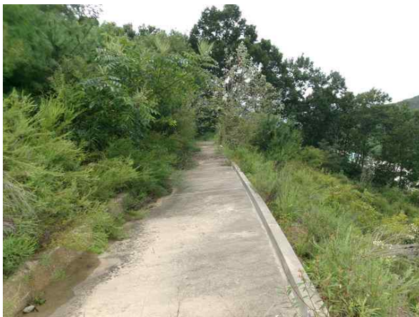
1소단 배수로 전경
