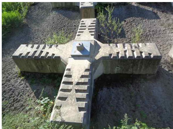
쑈크리트, 격자앵커 전경
