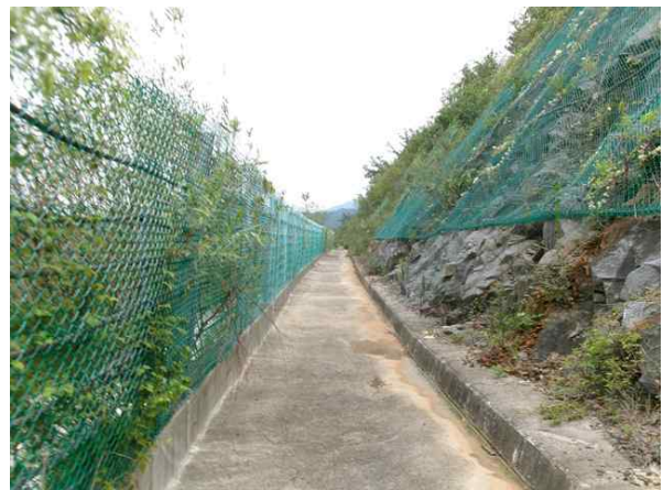
소단배수로 낙석방지울타리 전경
