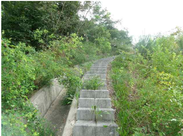
산마루측구, 점검계단 전경
