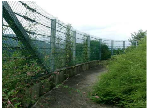
2소단 배수로 전경
