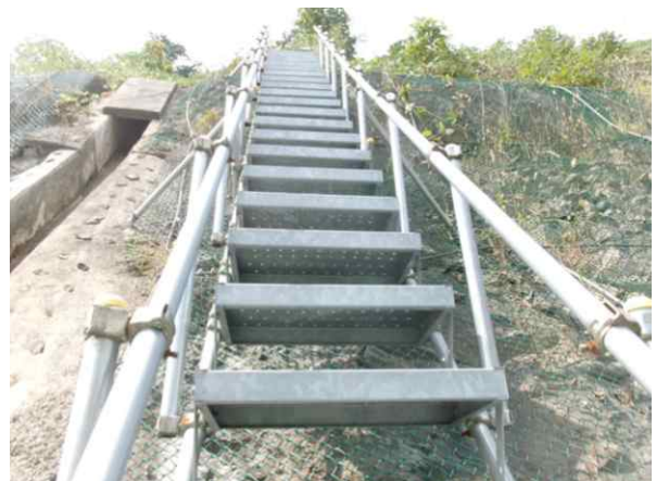
수직도수로, 점검계단 전경
