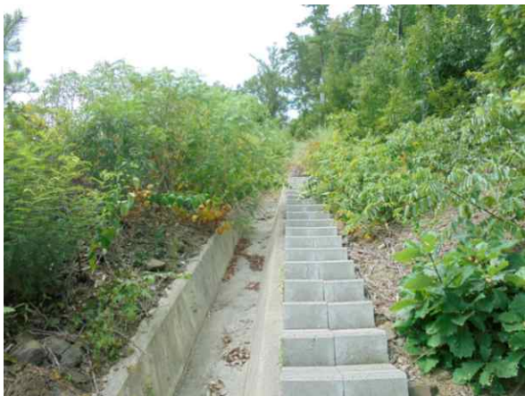
점검계단, 산마루측구 전경
