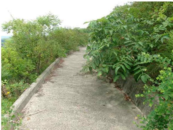
1소단 배수로 전경
