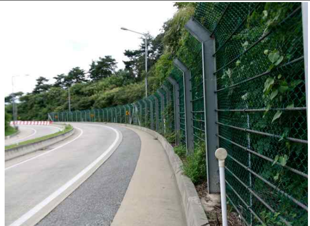
도로, 낙석방지울타리 전경
