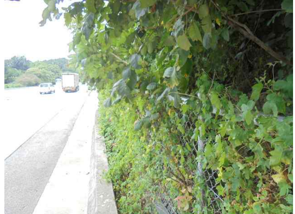
하단 도로부 전경
