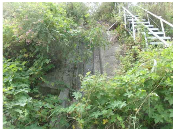
수직도수로, 점검계단 전경
