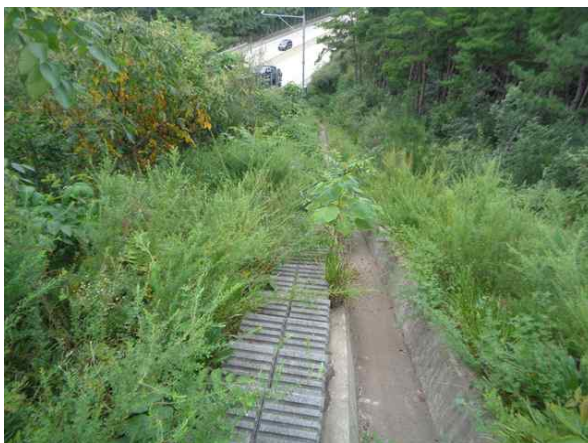
산마루측구, 점검계단 전경
