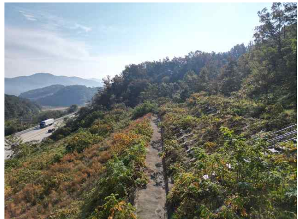
1소단 배수로 전경
