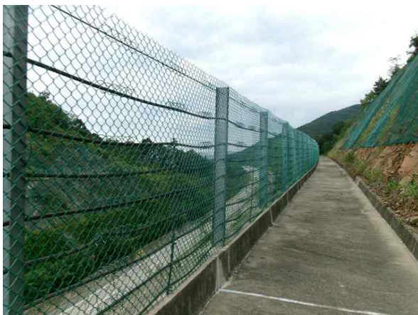
소단배수로 낙석방지울타리 전경
