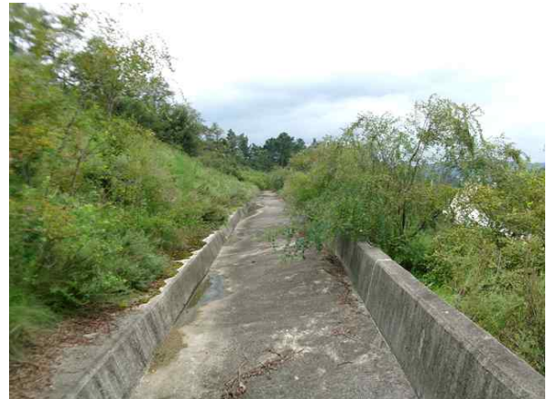
1소단 배수로 전경
