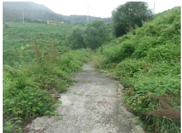
1소단 배수로 전경
