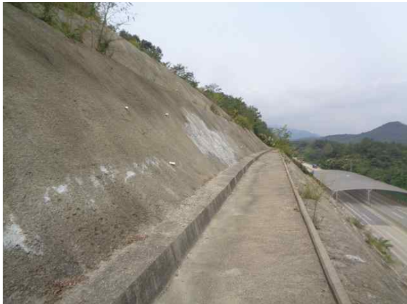
1소단 배수로 전경
