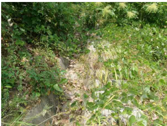
산마루측구, 점검계단 전경
