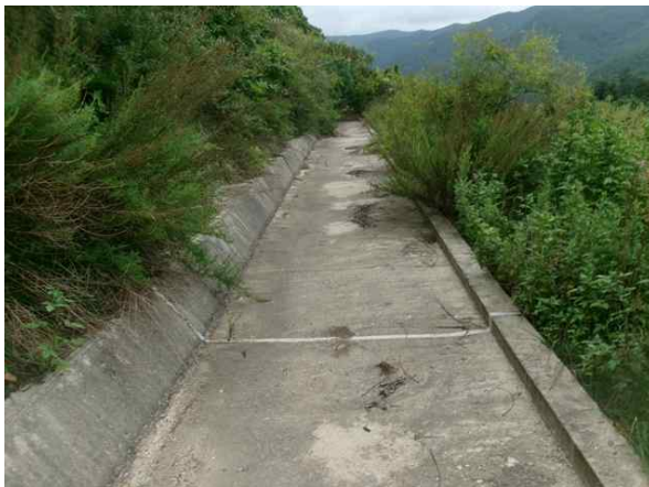
1소단 배수로 전경
