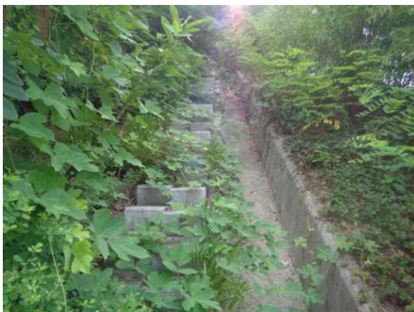
산마루측구, 점검계단 전경
