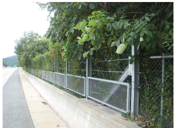
하단, 낙석방지울타리 전경
