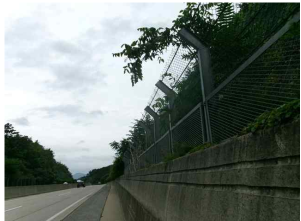
도로, 낙석방지울타리 전경
