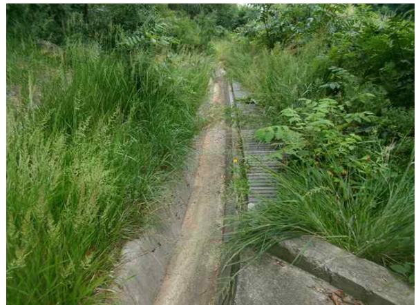
산마루측구, 점검계단 전경
