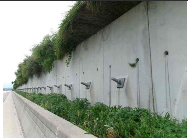
사면내 옹벽 전경
