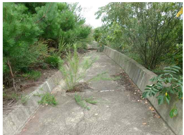
1소단 배수로 전경
