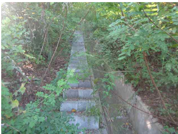
산마루측구, 점검계단 전경
