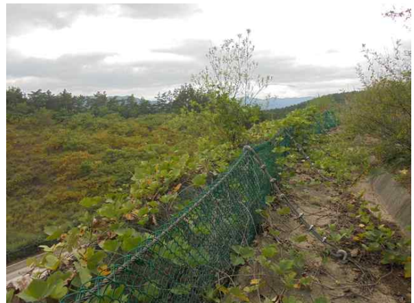
1소단 배수로 전경
