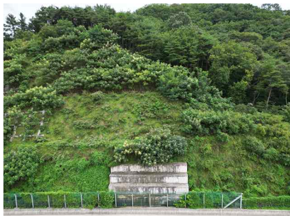
사면내 옹벽 전경
