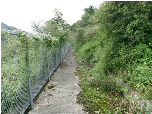
1소단 배수로 전경
