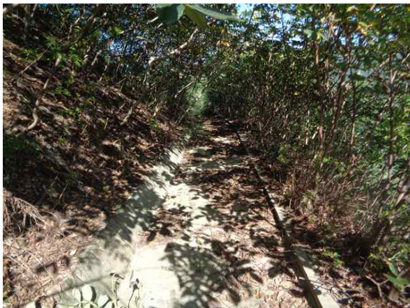
1소단 배수로 전경
