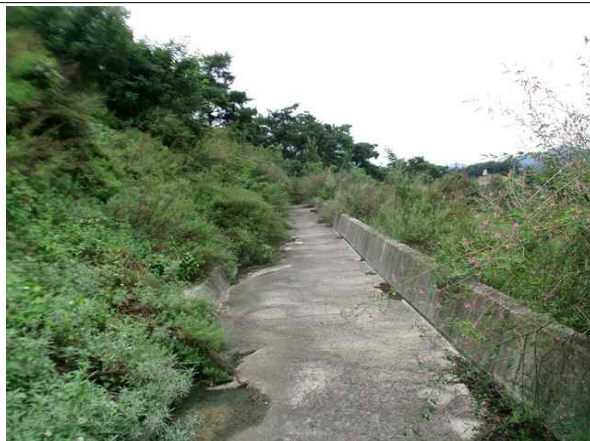
1소단 배수로 전경
