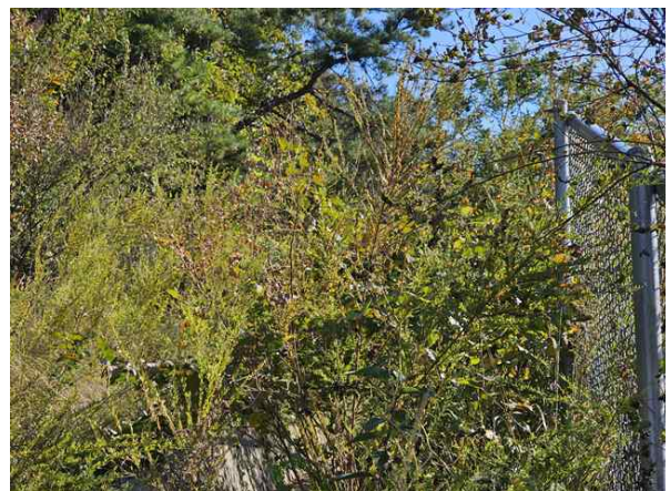
산마루측구, 점검계단 전경
