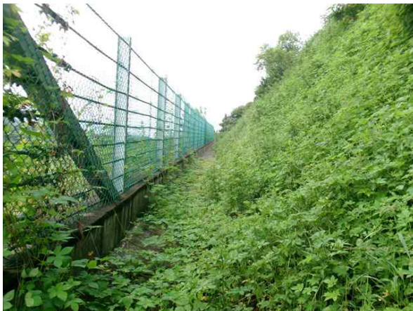
1소단 배수로 전경
