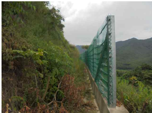
소단배수로, 낙석방지울타리 전경
