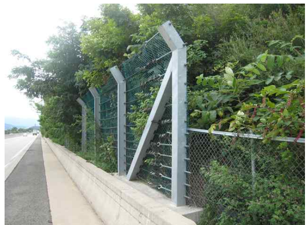
하단 낙석방지울타리 전경
