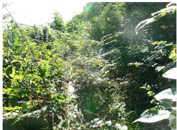
산마루측구, 점검계단 전경
