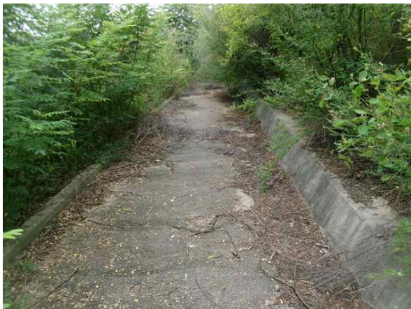
1소단 배수로 전경
