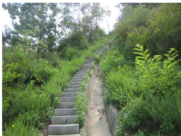
점검계단, 산마루측구 전경
